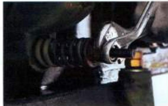
步骤 17：最后松开扳手，缓慢向下盘车，将轿厢盘到平层。
